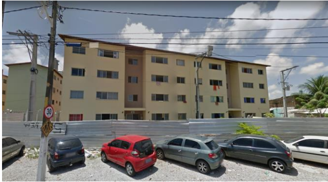
Figura 16 - Exemplo positivo: Residencial São Pedro, na Ribeira, antiga Comunidade do Maruim
