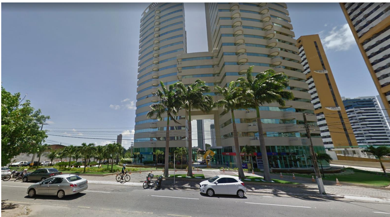
Figura 7 - Fachada do edifício CTC, na Av. Amintas Barros, em Natal
