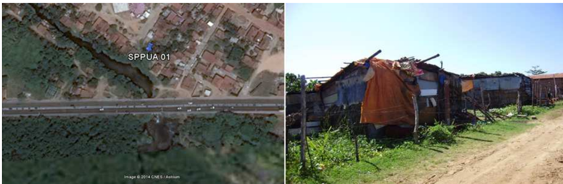
Figura 03 - Ponto 01: Aterramento do rio Doce, ocupações irregulares em suas margens.
