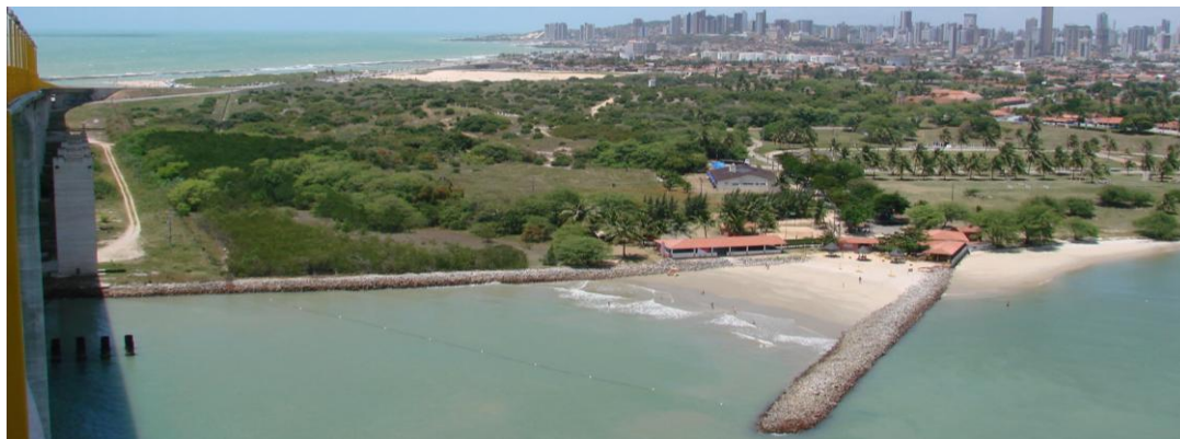
Figura 64. Foto da Área da ZPA7 vista da Ponte, em ponto próximo a Redinha. Apreensão da paisagem da ZPA 7 depois da inserção da Ponte.
