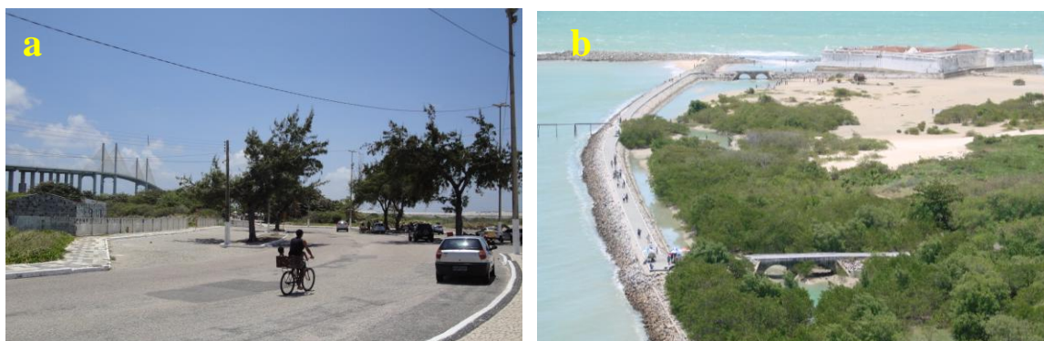
Figura 21. Vias de circulação (a) e acessos ao Forte dos Reis Magos (b).
