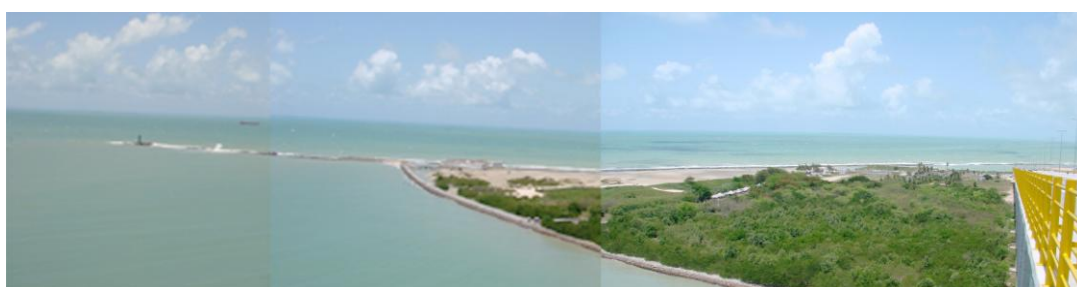
Figura 65. Foto da Área da ZPA7 vista da Ponte, em ponto próximo a Redinha. Apreensão da paisagem da ZPA 7 depois da inserção da Ponte.
