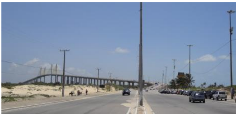
Figura 22. A Ponte Newton Navarro no sistema viário da ZPA 7.
