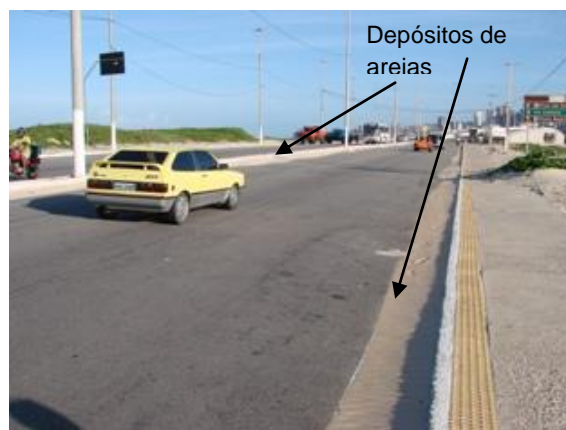
Figura 18 – Foto da avenida entre a praia (à esquerda da foto) e a planície de deflação terraplanada (à direita da foto) mostrando os depósitos de areias ao longo das guias entre o asfalto e a calçada transportados pelo vento tendo a praia como área fonte e a planície de deflação como área receptora.
