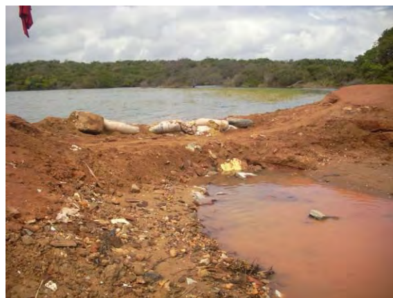
Detalhe do trecho alagado e dos sacos de areia para conter a água.
