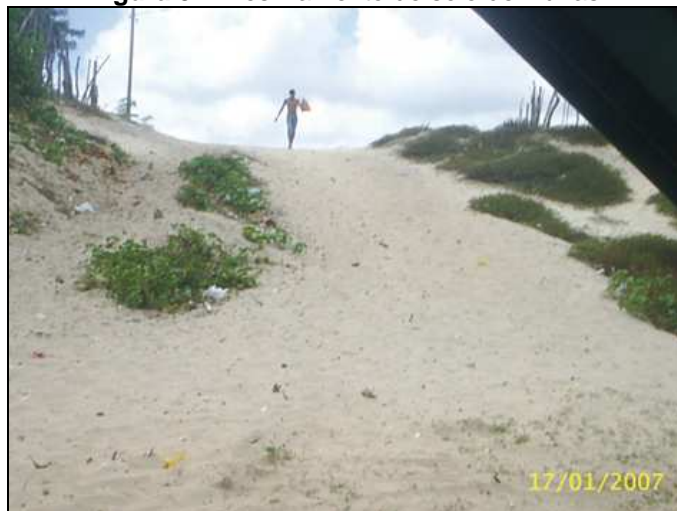
Figura 51: Deslizamento de solo de Dunas.
