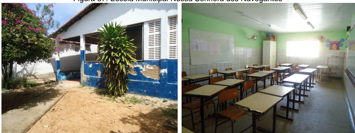
Figura 87: Escola Municipal Nossa Senhora dos Navegantes
