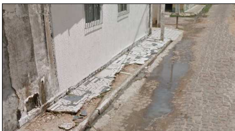
Figura 29: Rua sem sistema de esgotamento sanitário
