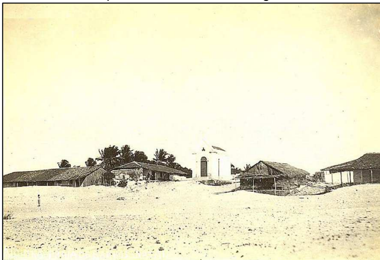
Figura 2: Foto da Capela Nossa Sra. dos Navegantes na década de 30
