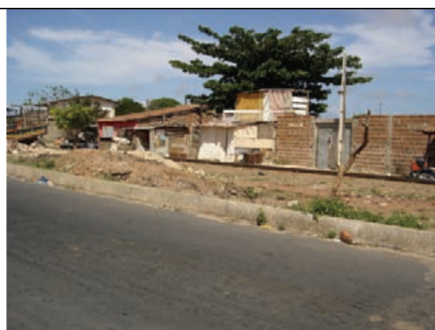
Moradias invadindo a faixa de domínio da via férrea, necessitando remoção
