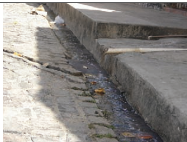
Necessidade de complementação da infra-estrutura de drenagem
