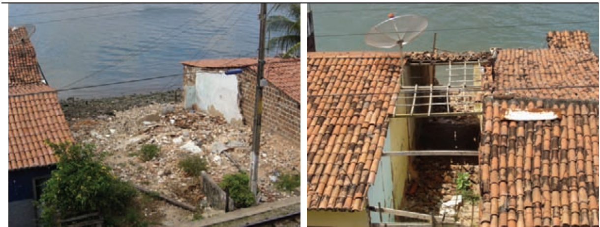
Ação da maré sobre as moradias
