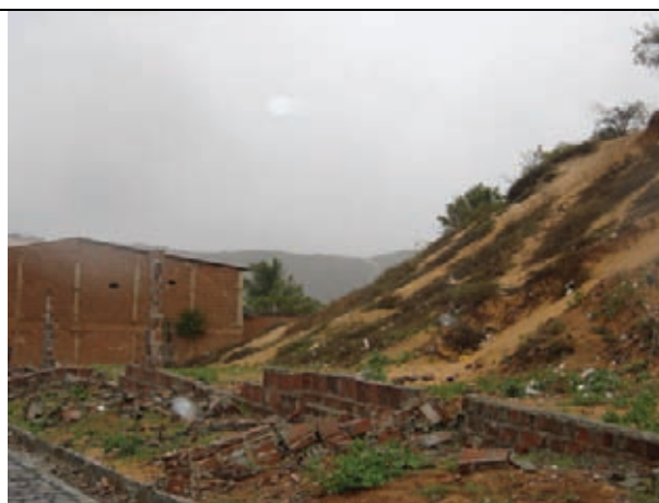
Deslizamento de dunas com solo exposto, pondo em risco as moradias próximas
