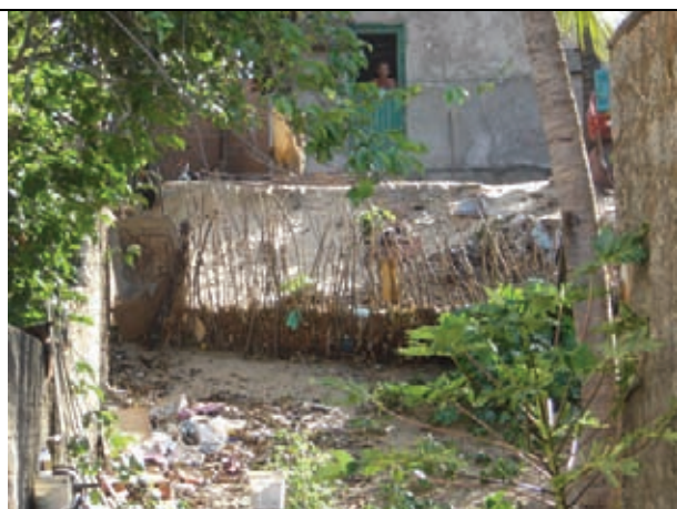
Processos de erosão
