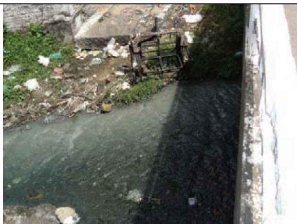
Carreamento de entulho, assoreando o Rio das Lavadeiras
