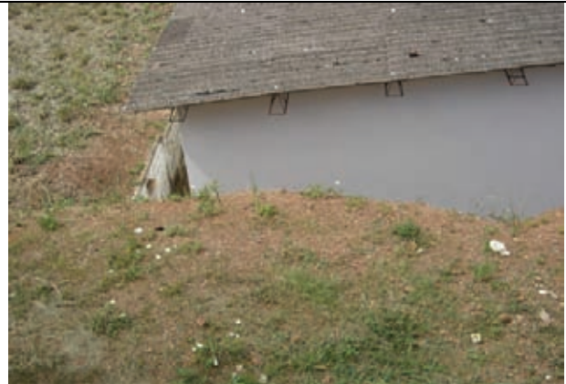
Barrancos com solo desprotegido, causando risco de queda de barreiras sobre moradias
