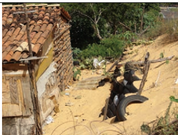
Deslizamento de Dunas atingindo moradias
