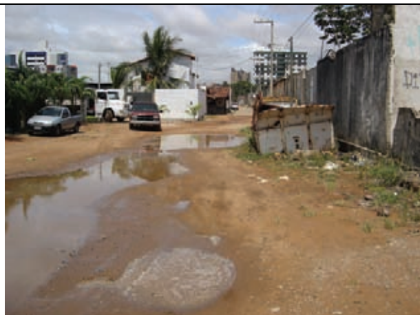
Problemas de alagamentos decorrentes da falta de rede de drenagem
