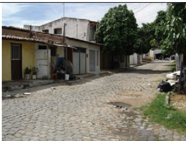
Problemas de alagamento superficial localizado
