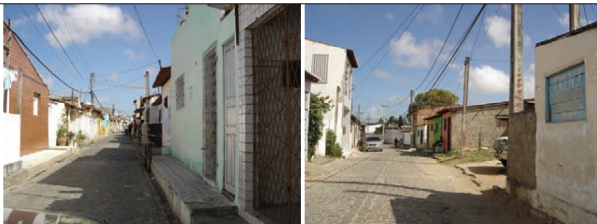
Ocupação irregular de calçadas, necessitando remoção de moradias
