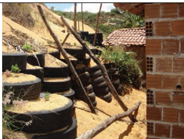
Queda de Barreiras: Risco às Moradias
