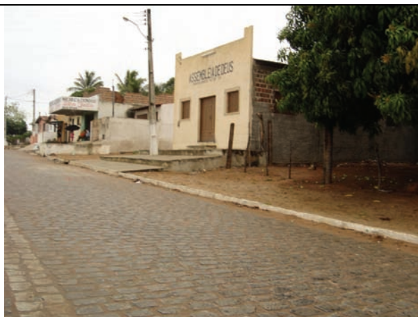
Ruas já pavimentadas, porém com pouca ou nenhuma rede de drenagem superficial
