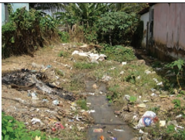
Carreamento de entulho obstruindo o escoamento superficial
