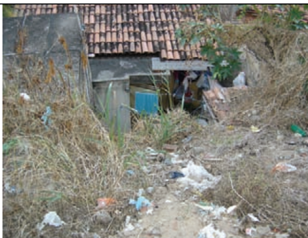
Carreamento de entulho
