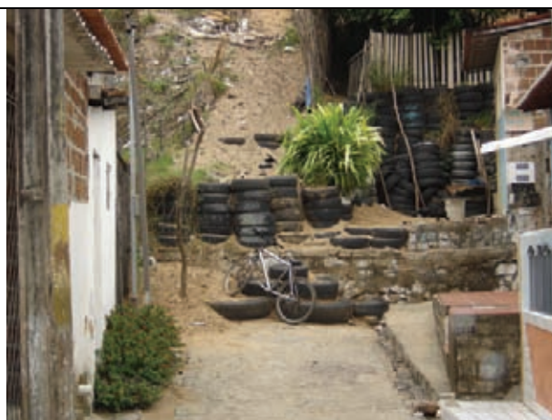
Deslizamento de dunas, pondo em risco as residências
