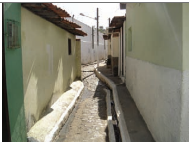
Becos estreitos e sujeitos a alagamentos por falta de rede de drenagem
