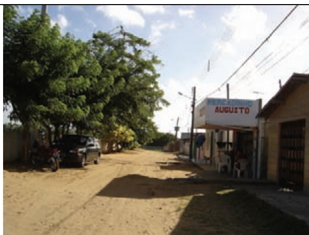
Falta de drenagem e pavimentação
