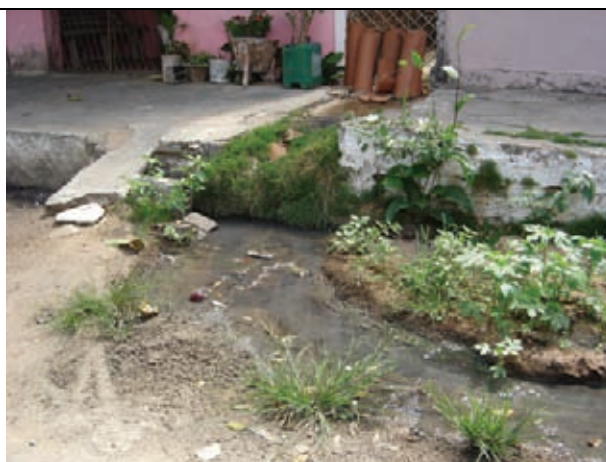
Problemas decorrentes da falta de infraestrutura de drenagem e pavimentação
