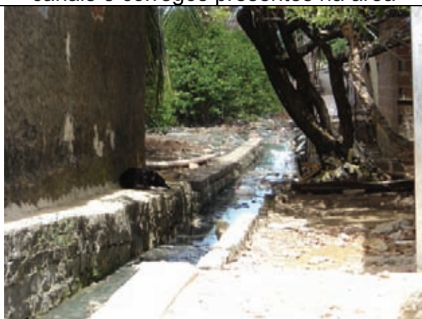
Necessidade de limpeza e proteção de canais responsáveis pela drenagem
