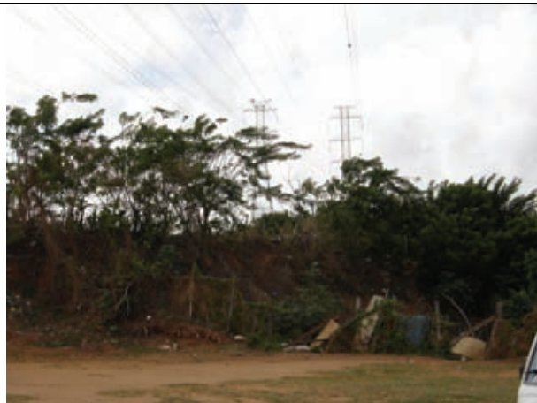
Ocupação da faixa de domínio da rede de alta tensão
