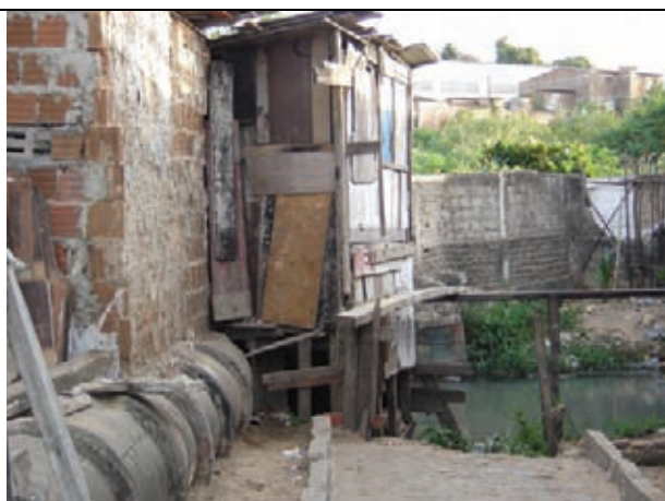
Ocupação Irregular e Obstrução do Rio das Lavadeiras por moradias
