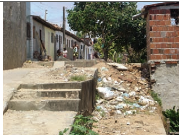
Problemas de carreamento de entulho
