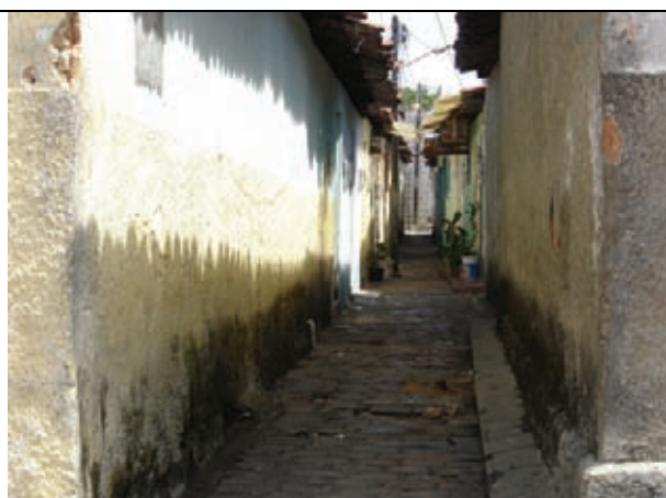
Becos estreitos sem micro-drenagem
