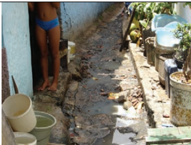
Falta de saneamento básico
