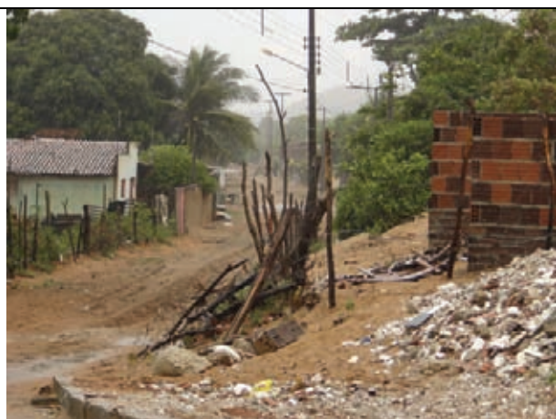
Carreamento de entulho promovendo amontoamento deste material e obstrução do escoamento d'água, gerando alagamentos
