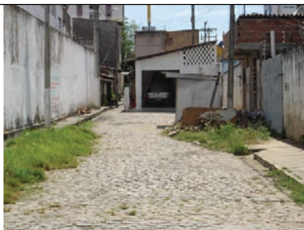
Ocupação irregular da Rua Perito José Lourenço
