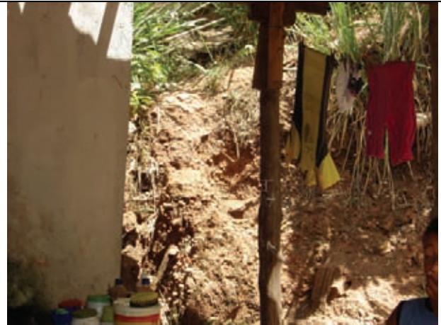
Queda de barreiras que atingem as moradias
