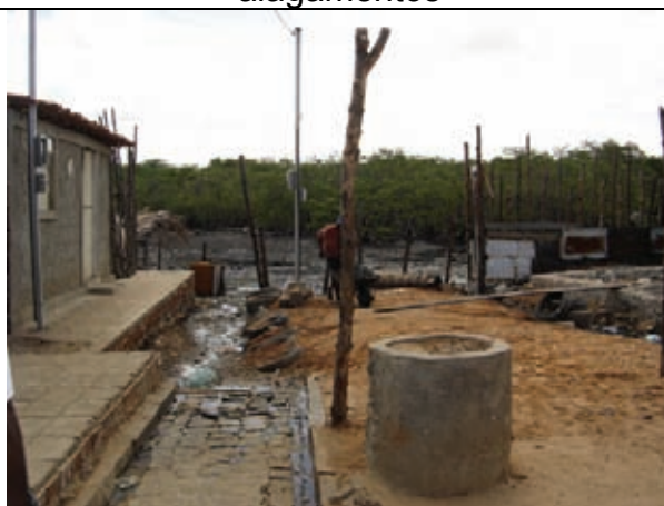
Invasão de área de preservação permanente de mangue
