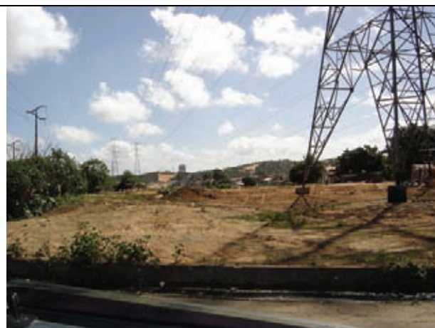
Ocupação Irregular de Faixa domínio rede alta tensão
