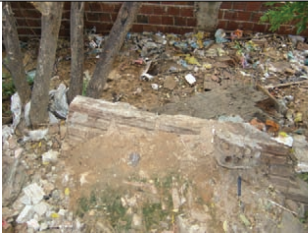
Carreamento de entulho, amontoando-se e obstruindo o escoamento superficial
