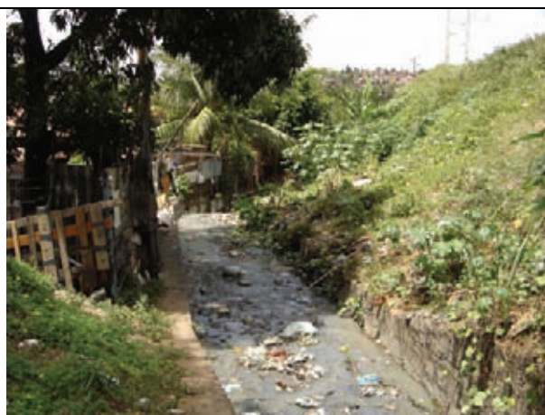
Necessidade de limpeza de canais e de córregos
