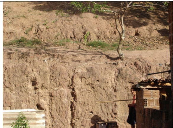
Necessidade de retaludamento
