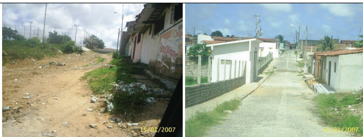
Problemas com áreas sujeitas a alagamentos pluviais
