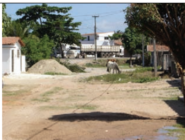
Áreas baixas sujeitas a alagamentos com falta de pavimentação
