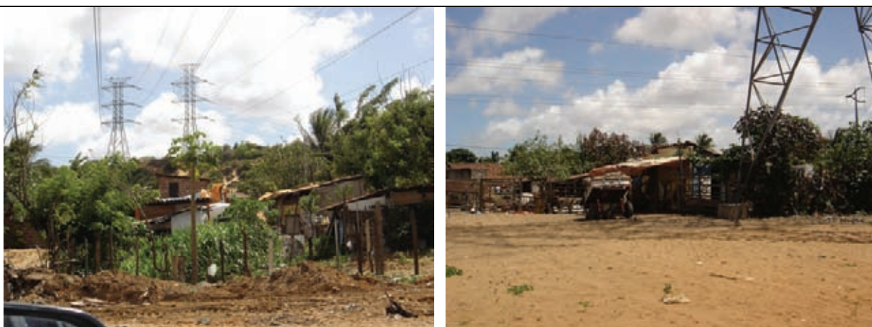
Ocupação da faixa de domínio da rede de alta tensão
