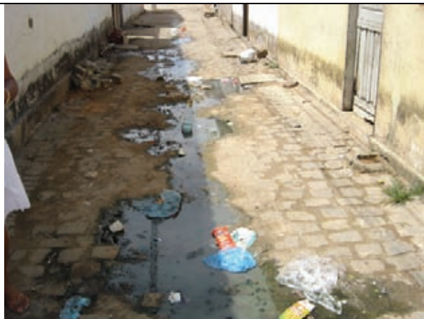
Alagamentos por falta de micro-drenagem
