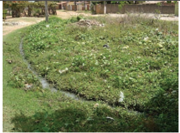
Problemas de alagamento decorrentes da falta de rede de drenagem
