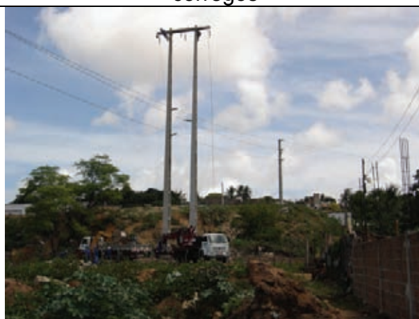
Invasão de faixa de domínio de rede de alta tensão
