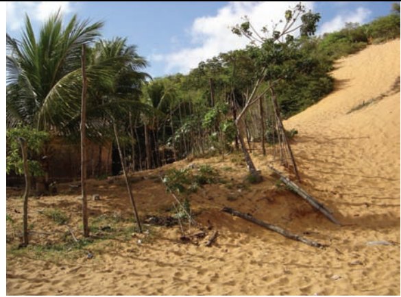
Deslizamento de dunas colocando moradias em risco
