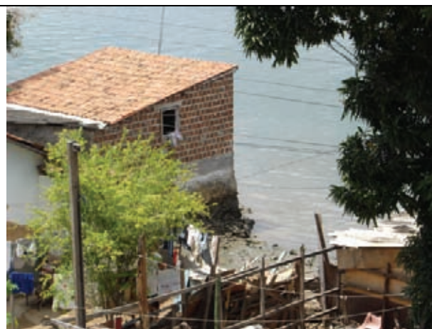
Ação da maré sobre as moradias
