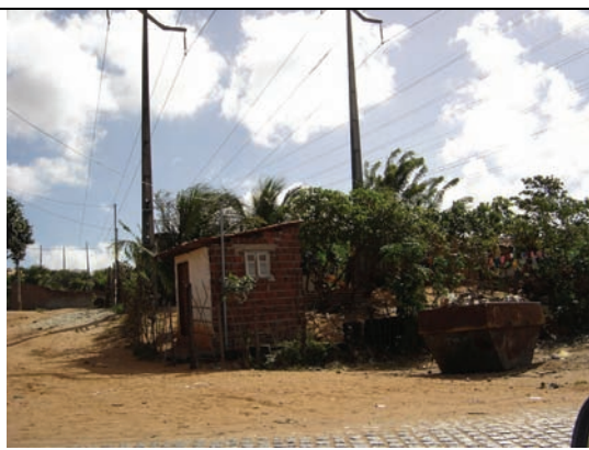
Ocupação da faixa de domínio da rede de alta tensão
