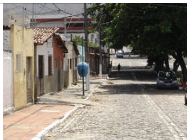
Ruas com declividades, sujeitas ao acúmulo d'água por falta de drenagem
