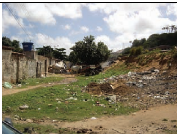
Ocupação da faixa de domínio da via férrea
