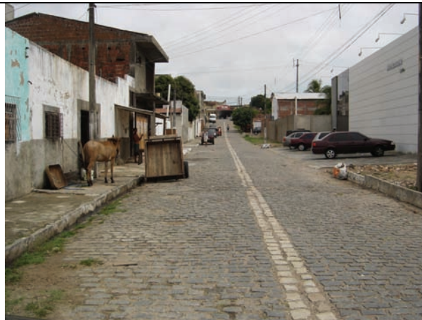
Ruas com depressões e deficiência drenagem
