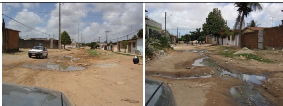
Problemas de alagamentos e falta de pavimentação das ruas
