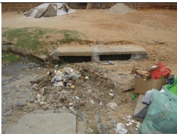
Carreamento de entulho em direção a rede de drenagem existente
