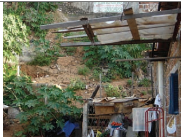
Problemas de queda de barreiras
