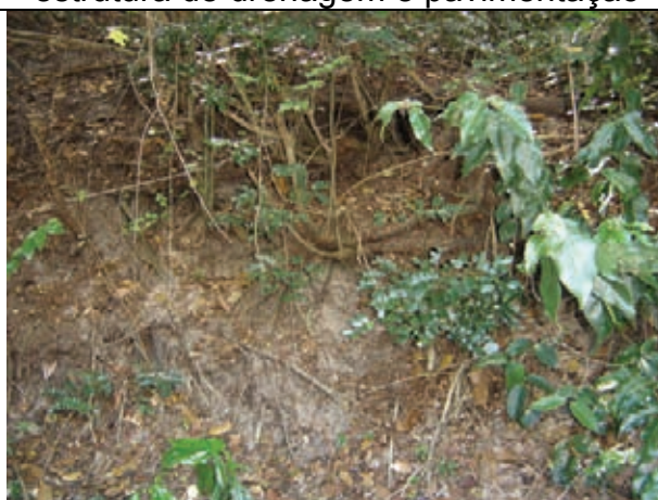
Erosão com exposição de raízes da vegetação
