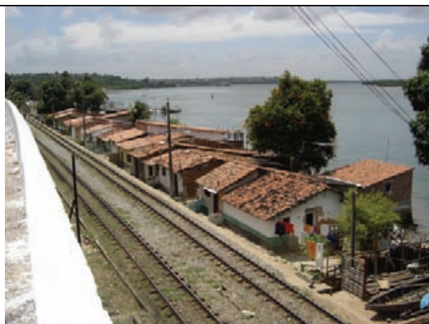
Invasão de faixa de domínio da via férrea
