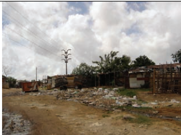
Carreamento e amontoamento de entulho, obstruindo o fluxo superficial
