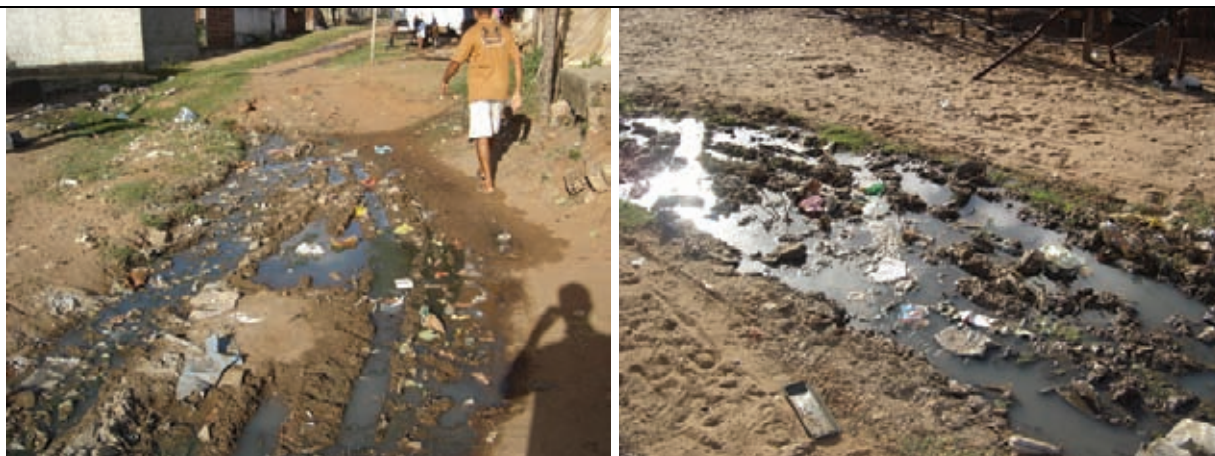
Problemas de alagamentos decorrentes da falta de rede de drenagem superficial
