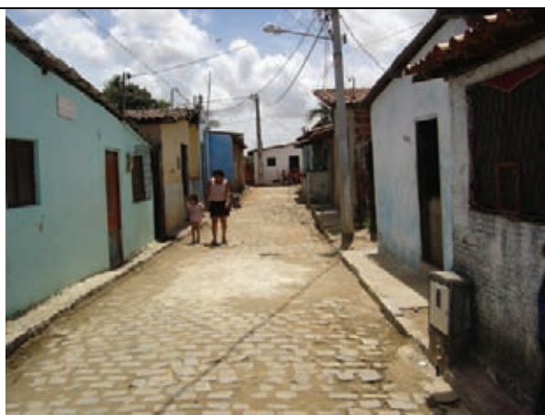
Ruas sem drenagem, sujeitas a alagamentos
