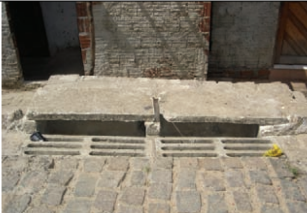
Sistema de drenagem existente com necessidade de limpeza
