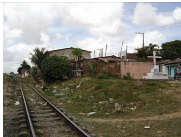
Invasão da faixa de domínio da via férrea
