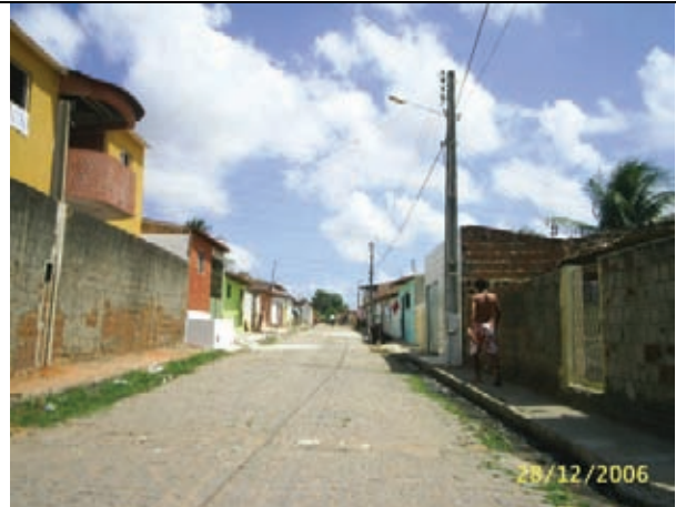
Ruas Pavimentadas, porém sem rede de drenagem
