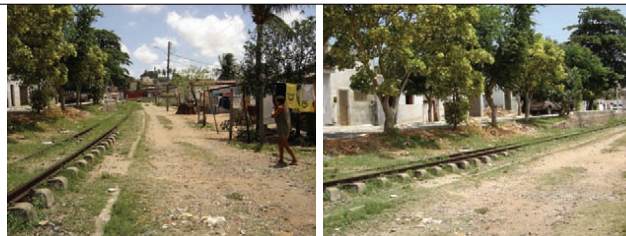
Invasão da faixa de domínio da via férrea
