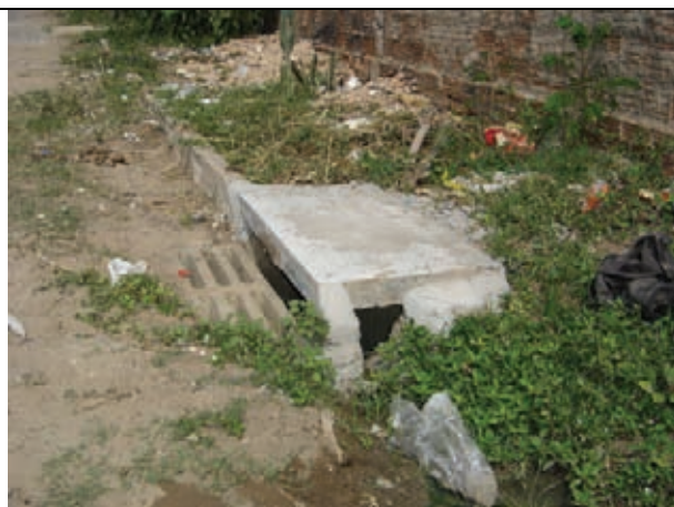
Carreamento de entulho e necessidade de limpeza do sistema de drenagem
