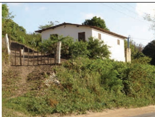
Invasão faixa de servidão de estrada
