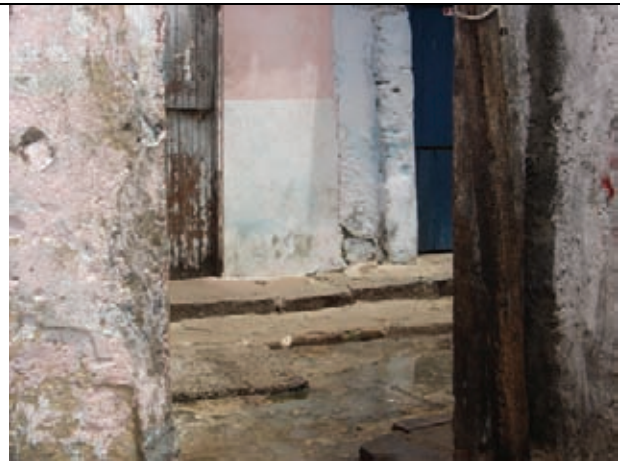
Alagamento das ruas
