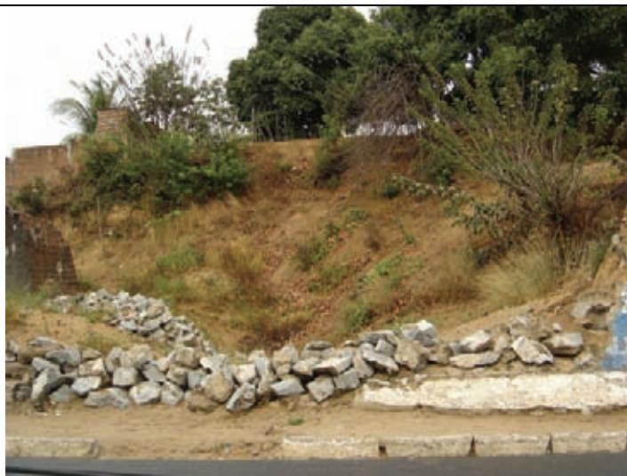
Erosão e queda de barreiras em encostas íngremes e com pouca ou nenhuma proteção superficial
