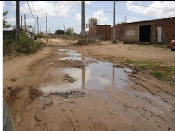
Problemas de alagamento em ruas sem pavimentação e rede de drenagem
