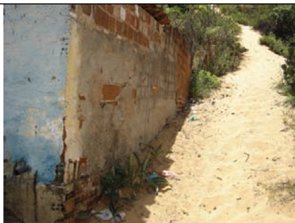
Deslizamento de Dunas
