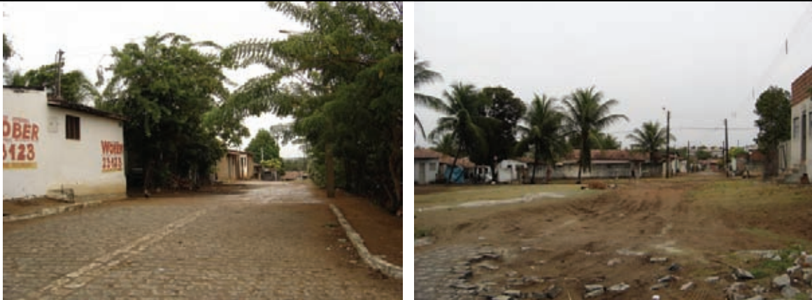
Problemas de alagamentos e pavimentação deficiente e/ou ausente
