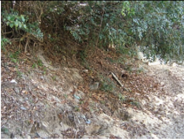
Deslizamento de Dunas com solo exposto
