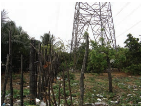
Acúmulo de entulho carregado pelas águas escoadas superficialmente
