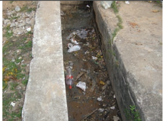
Necessidade de limpeza do sistema de drenagem existente
