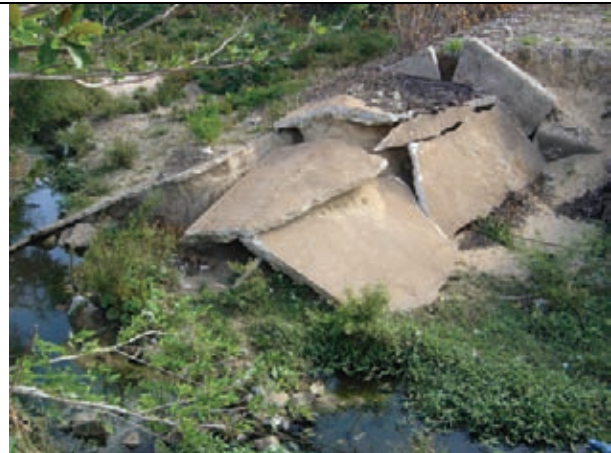
Destruição de estrutura de contenção da Lagoa do Sapo
