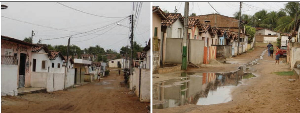
Problemas de alagamentos decorrentes da ausência de drenagem e de pavimentação
