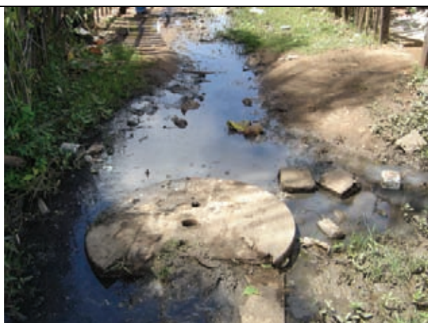
Alagamento por falta de rede de drenagem
