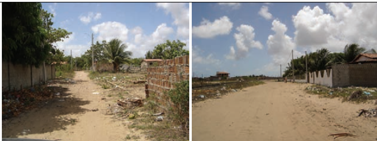
Carreamento e acúmulo de entulho em áreas planas, de pouca declividade
