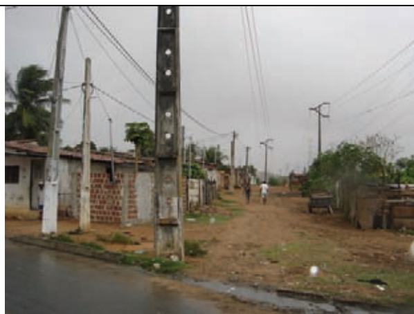
Ocupação de Faixa de domínio de rede de alta tensão
