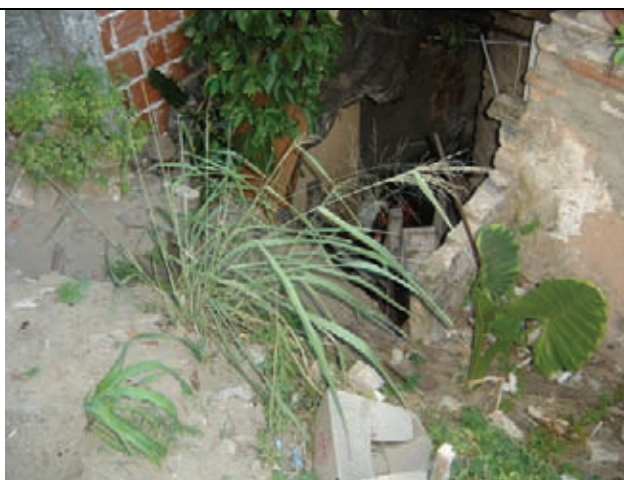
Deslizamento de Dunas
