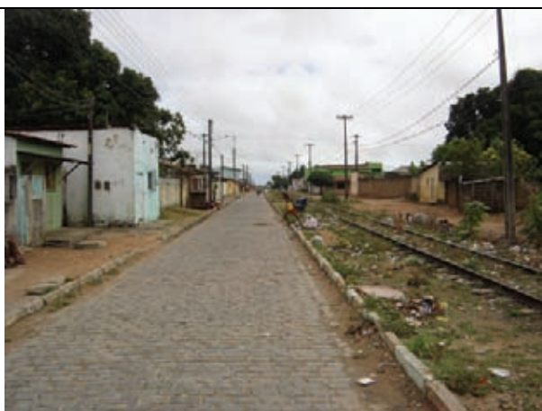
Amontoamento de entulho carregado
