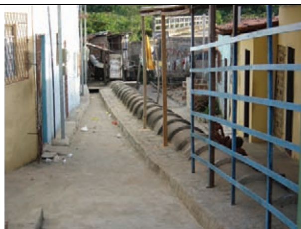
Construções Irregulares juntas às margens do Rio das Lavadeiras
