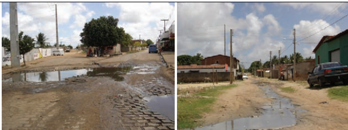
Problemas com alagamentos pluviais
