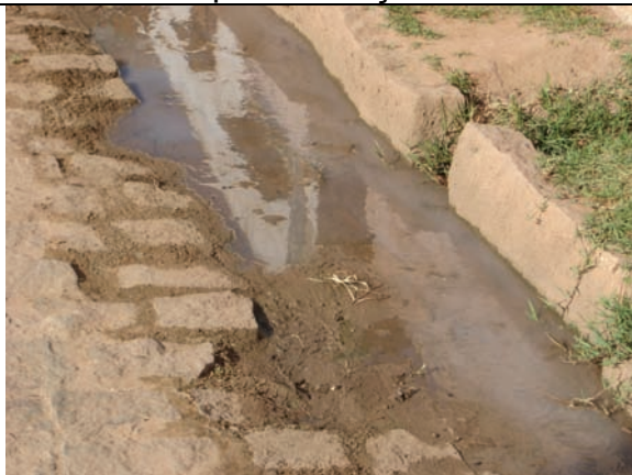
Problemas de micro-drenagem
