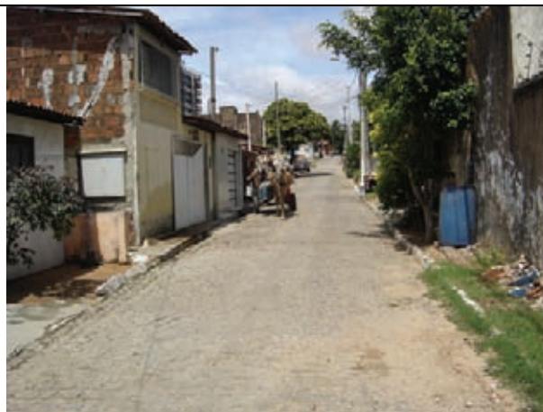
Ocupação irregular de calçadas, necessitando desocupação
