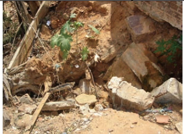
Erosão pela presença de solos expostos, afetando as moradias
