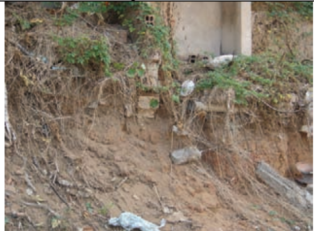
Processos erosivos que necessitam ser contidos
