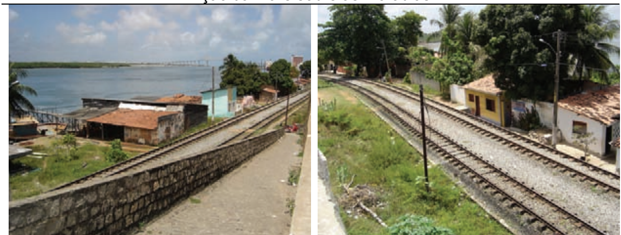
Invasão de faixa de domínio da via férrea
