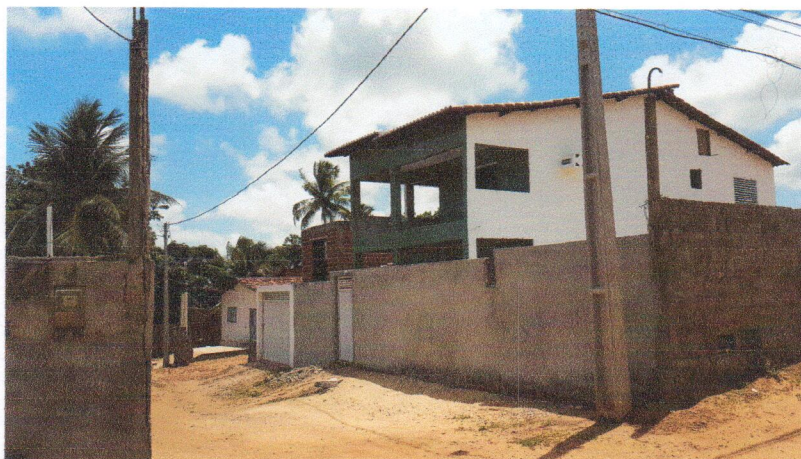
Figura 12. Lado Oeste - Loteamento Bosque do Rio
