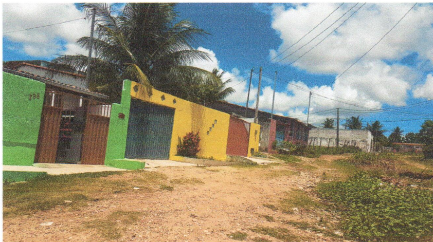
Figura 14. Lado Oeste - Loteamento Bosque do Rio
