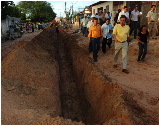
Foto 1: Prefeito Carlos Eduardo em visita às obras do PAC no bairro Nossa Senhora da Apresentação.
