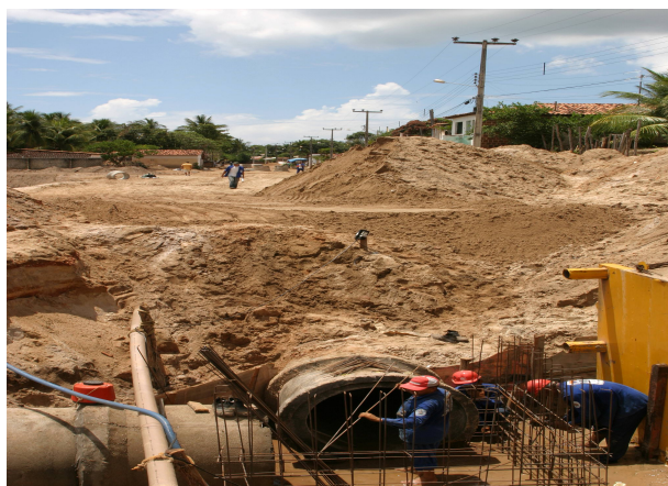
Foto 4: Obras de saneamento.
