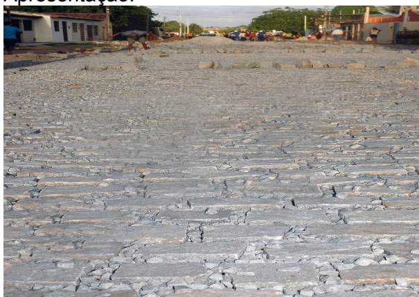
Foto 3: Rua sendo pavimentada.
