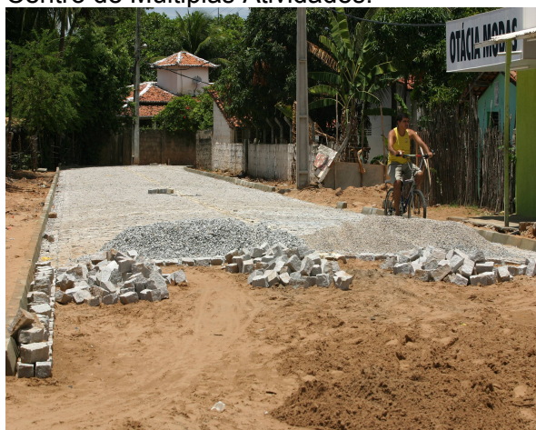
Foto 5: Rua recebendo pavimentação.
