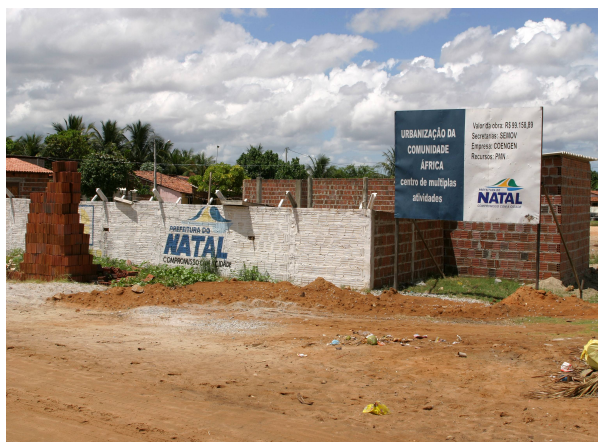
Foto 3: Terreno onde será construído o Centro de Múltiplas Atividades.
