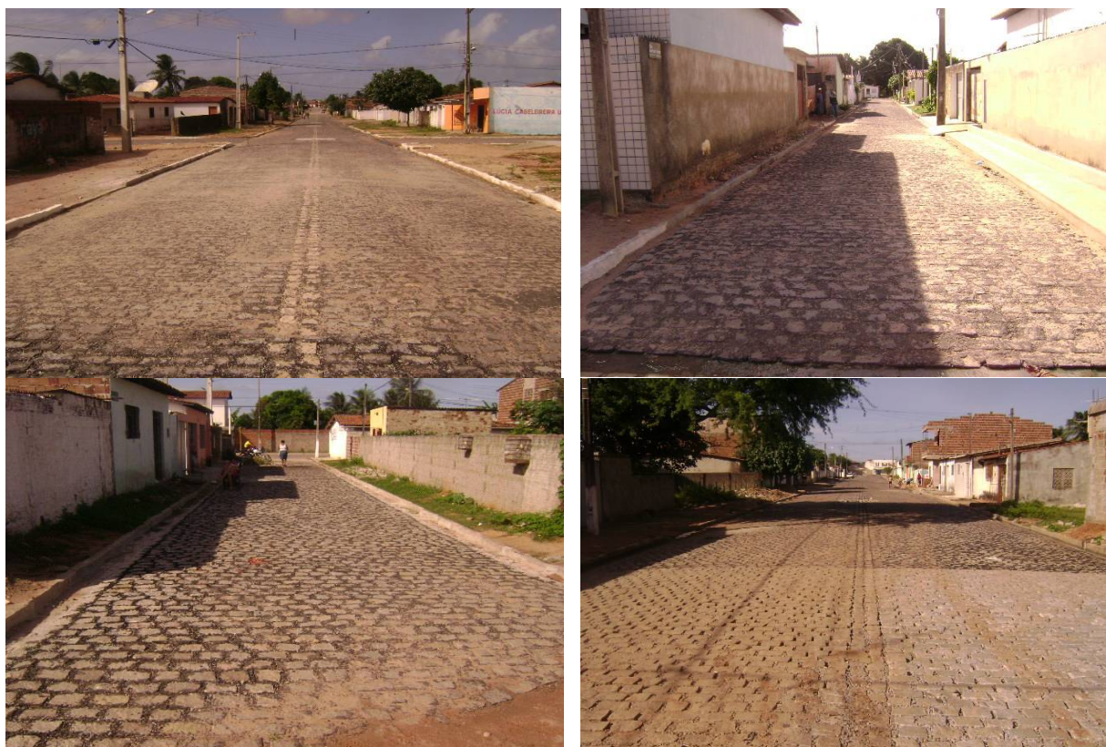
Fotos 5, 6, 7 e 8: Ruas beneficiadas com esgotamento sanitário, drenagem e pavimentação no bairro Nossa Senhora da Apresentação.
