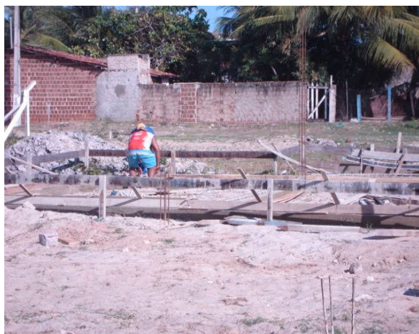
Foto 1: Terreno onde está sendo construída
