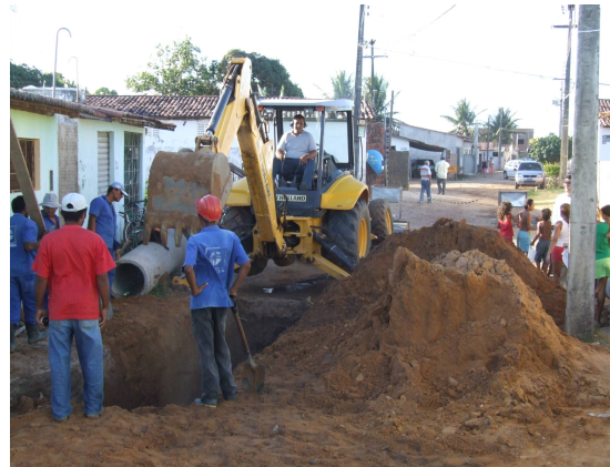
Foto 2: Máquinas e trabalhadores executando as obras de saneamento.
