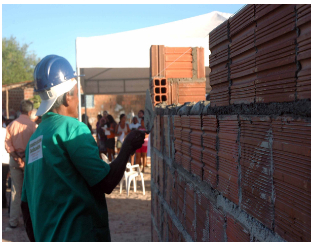
Foto 2: Unidade Habitacional sendo
